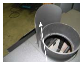
Bouclier thermique installé
